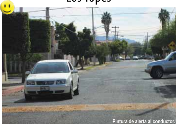
Pintura de alerta al conductor.
