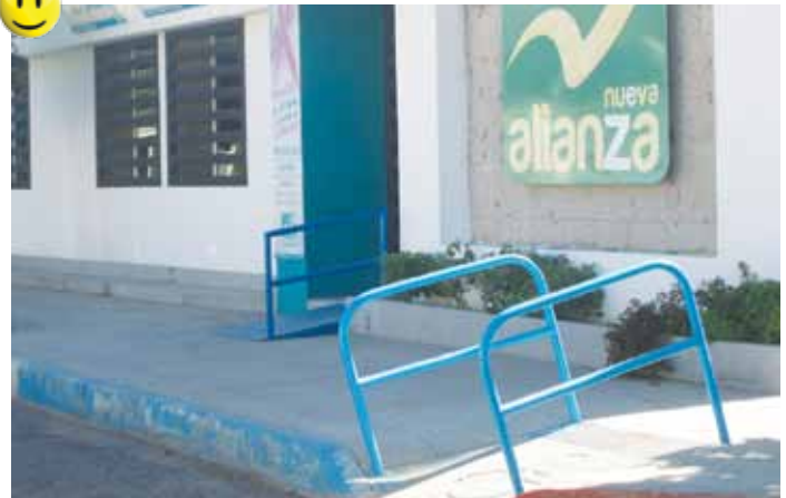
Instalación de rampas.
